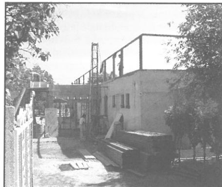
Folyik a Szabadság úti óvoda épületének bővítése
