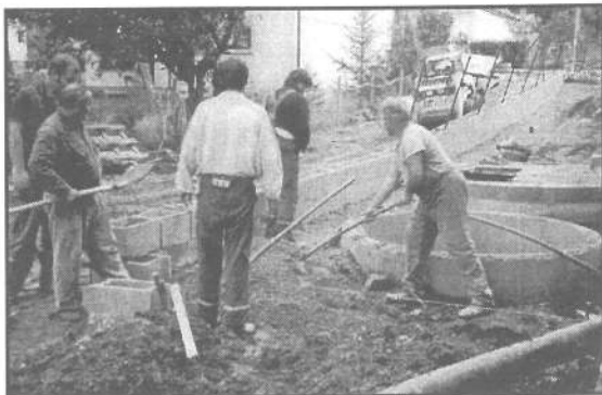
Épül a Pozsonyi utcai átemelő
