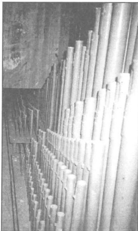
Az orgona belső sípsorai ón és ólom ötvözetéből készültek
