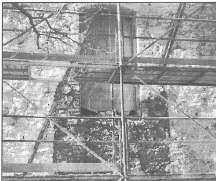
A vakolat leverése után láthatóvá váltak a korábbi félköríves ablakok, amiket a templom bővítésekor befalaztak.
