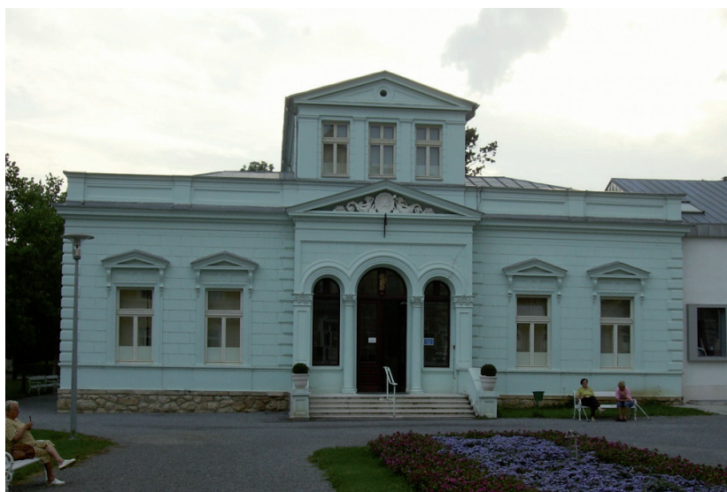
3. ábra: A felújított Márványfürdő
