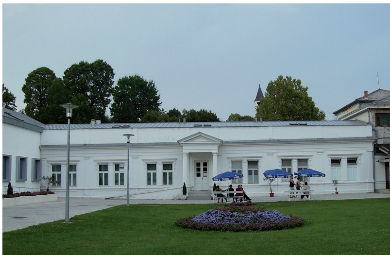
2. ábra: A felújított Kőfürdő
