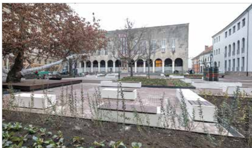
Már csak néhány mozzanat van hátra a Bartók Béla tér felújítási munkálataiból. A terület teljesen átalakult: a medence eltűnt, apró kavicsok helyett térkövön sétálhatunk. A kis padoknak köszönhetően igazi közösségi térre érkezhetünk a belváros ezen részén.
