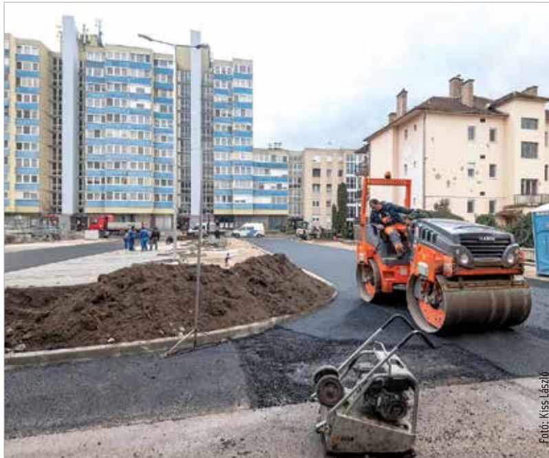
Újabb ötvenhárom parkolóhelyet építenek a színház mögött
