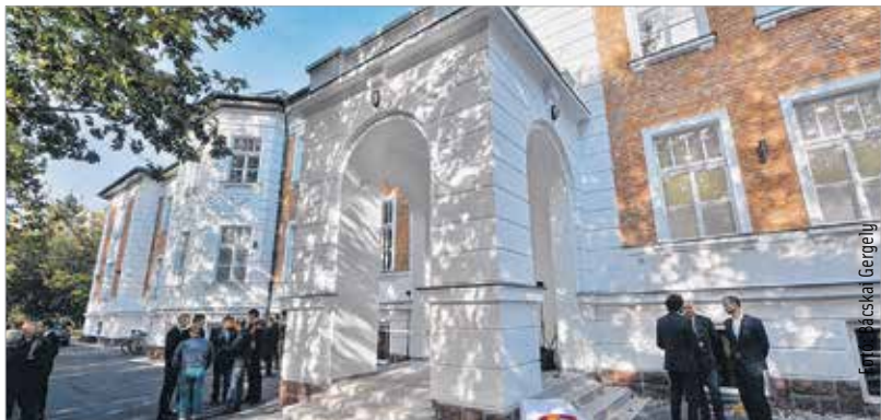
A kivitelezés teljes költsége közel félmilliárd forint volt
