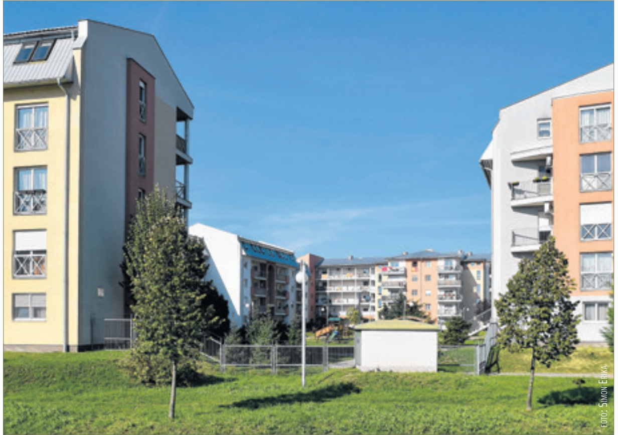
A tetőhéjazat helyreállítása ezen a héten befejeződik
