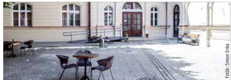
A belső udvarban majdnem teljesen leverték a vakolatot, hogy biztosítsák a kiszáradást
