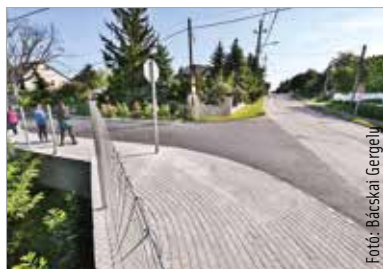
Térköves járdát és kétirányú közlekedésre alkalmas, kiszélesített útsatlakozást alakítottak ki, és a megdőlt villanyoszlopot is cserélték
