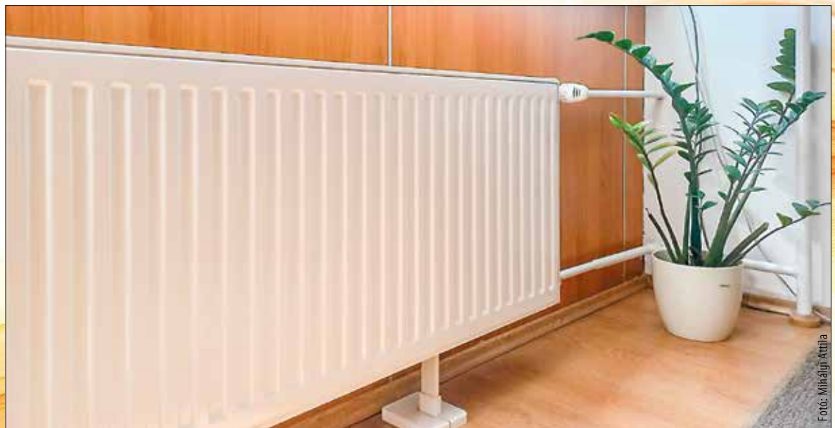
A ház fűtési rendszere érdekében végzett művelet okozta esetleges kellemetlenségekért a SZÉPHŐ Zrt. a felhasználók szíves türelmét és megértését kéri!
