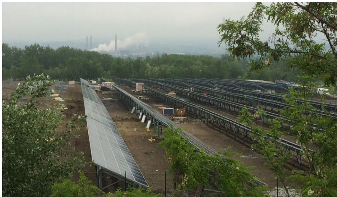
Előtérben az épülő jövő, háttérben a még üzemelő múlt
