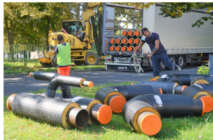
Cserélik a fűtőcsöveket a Torna patak partján a Primer szakemberei (Fotó: Györkös)
