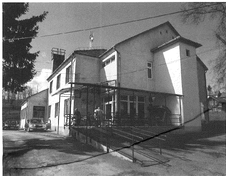
Az Idősek Otthona felújítására mintegy 20 millió forintot nyertünk, melyből 18.5 millió forintot építésre, 1.5 millió forintot eszközökre fordíthatunk. A kastélyépületen külső nyílászáró cserére-, valamint mindhárom épületen külső hőszigetelésre kerül sor, s végül új vakolatot is kap az intézmény. A beruházás, a tervek szerint idén ősszel befejeződik.
