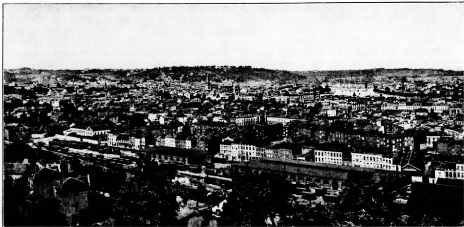
Gesamtansicht von Lüttich.
