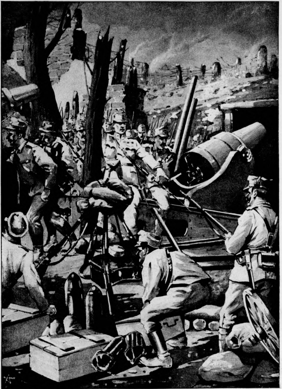
Einnahme des Panzerwerkes „Casa Ratti“ bei Artero.
