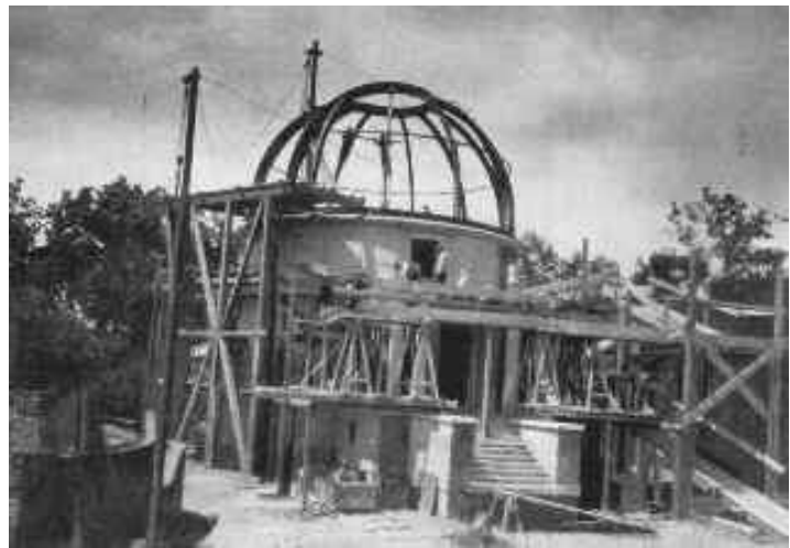
Az épülő kupola 4
