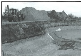
A szennyvíztisztító telepen elkészült a szennyvíztisztító építéséhez a szerelőbeton, és folyik az iszaptároló alapozása
