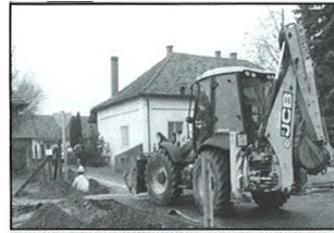
Március 18-a óta folytatódik a főútvonalak mentén a szennyvízcsatorna építés.
