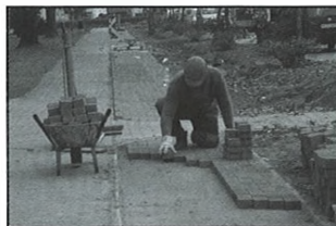
Elkészült a kerékpárút belterületi szakasza
