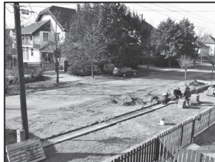
A csapadékvíz elvezetésére szikkasztóárok épült a Rákóczi utcában.
