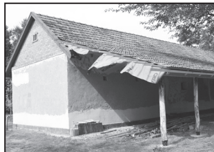
Az Állatsimogatóban szalastakarmány tároló készül.
