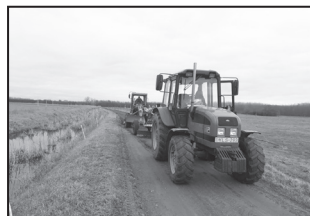
Balástya külterületén megkezdődött a dűlőutak javítása.
