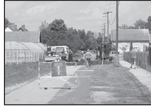
A Kodály utcában megkezdődött a csatorna felújítása.
