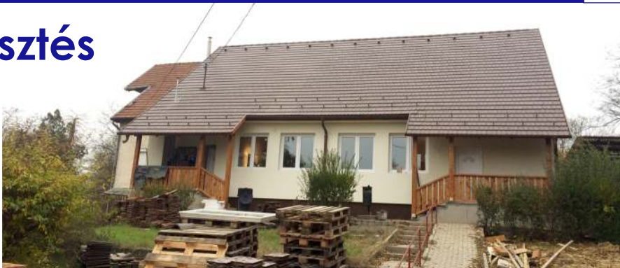
A Védőnői és Gyermekorvosi Rendelő épületének felújítása
