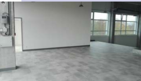
Galéria tornacsarnok feletti része
