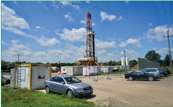
8. kép: Fúróberendezés a Napfény bevásárlóközpont mögött
