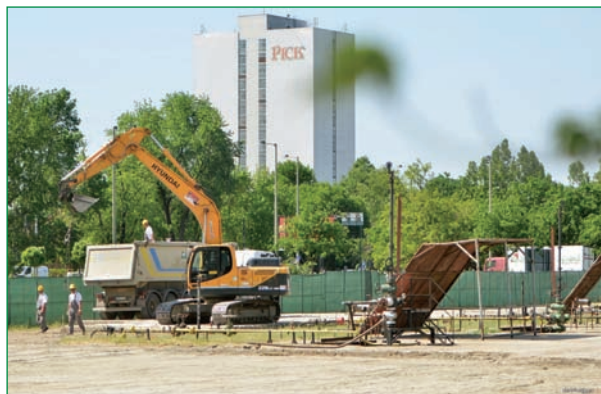
7. kép: Kútmunkálati védőlemezek
