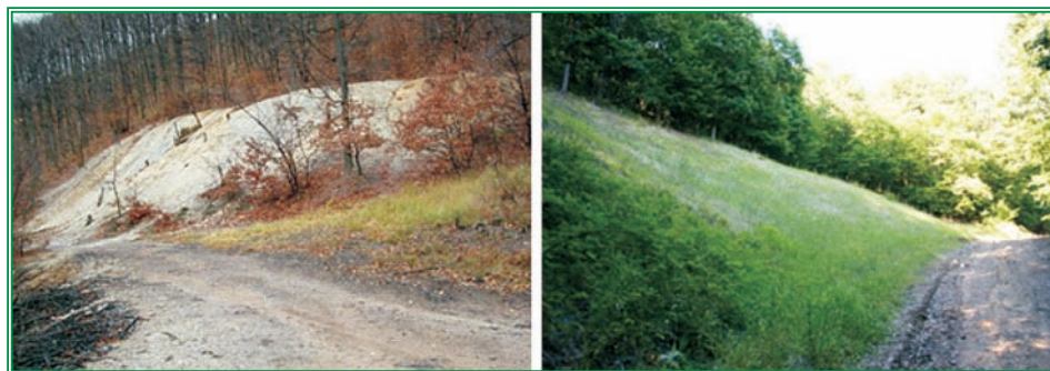
2. kép: Új-Károly táró I. meddőhányó a kármentesítés előtt 2006-ban és a kármentesítés után 2017-ben
