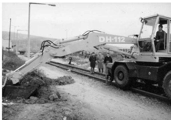
7. kép: Az első kétéltű kotrógnak üzemi próbája
