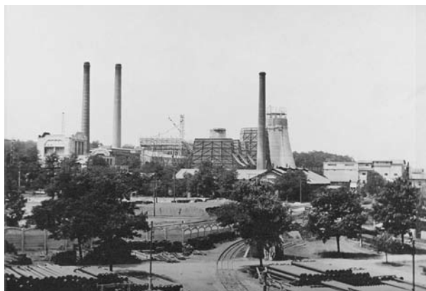
4. kép: Új hűtőtorny épül
