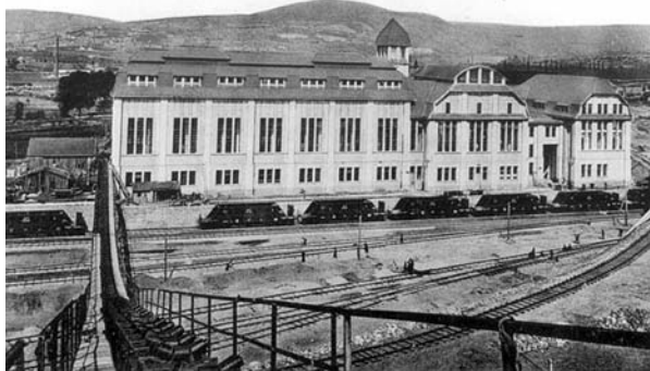
11. kép: A felrobbantott pécsújhegyi erőmű képe a 20. sz. elején
