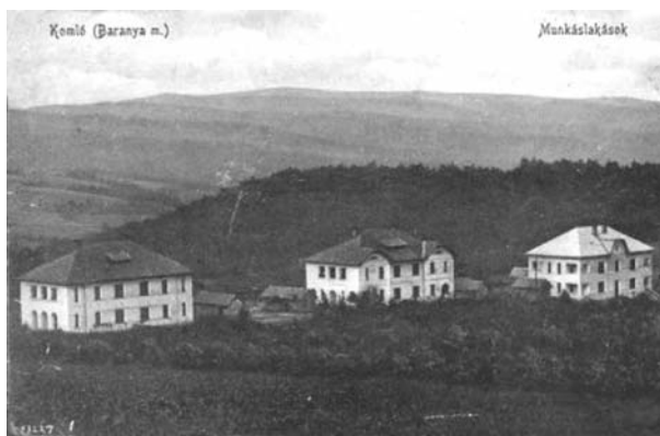
5. kép: Komló Bánya, Újakna melletti lakótelep (1925)
