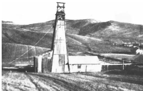
1. kép: Fauck-Express II. típ. berendezés a Bükkszék-I. fúrási ponton
