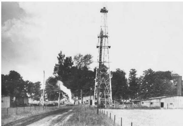
2. kép: Mihályi-1 sz. fúrési ponton felszerelt R-1 rotary berendezés
