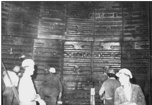
■ 1. ábra. Az elpárolgató hűtőlapok szerelése
