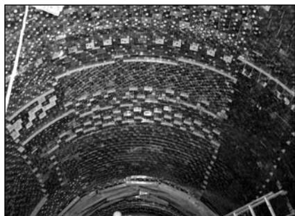
■ 6. kép. A konverter falazata
