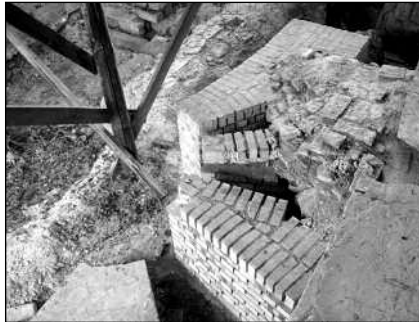
■ 1. kép. A Valide Szultána fürdő kemencéjének tűztere a sugaras fűtőcsatornákkal
