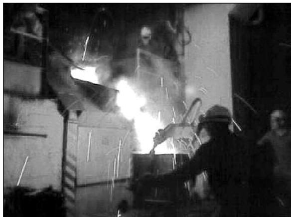
■ 8. ábra. Csapolás az új 500 kg-os indukciós kemencéből, 1977
