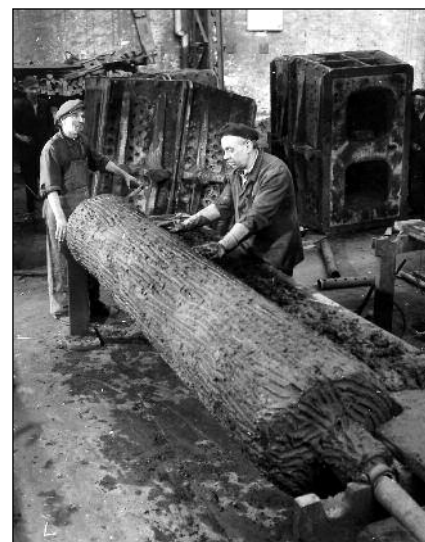
■ 6. ábra. Fúrógéphenger sármagjának készítése
