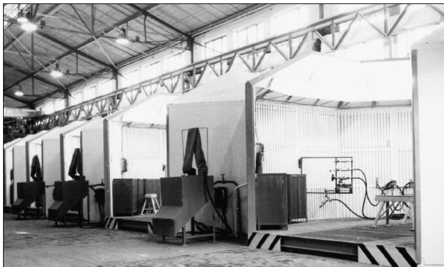
■ 12. ábra. Korszerűsített öntvénytisztítás az 1. sz. vasöntödében
