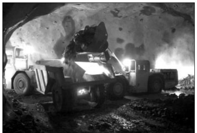
11. ábra: Tárolókamra-építés (a jövészett kőzet rakodása)
