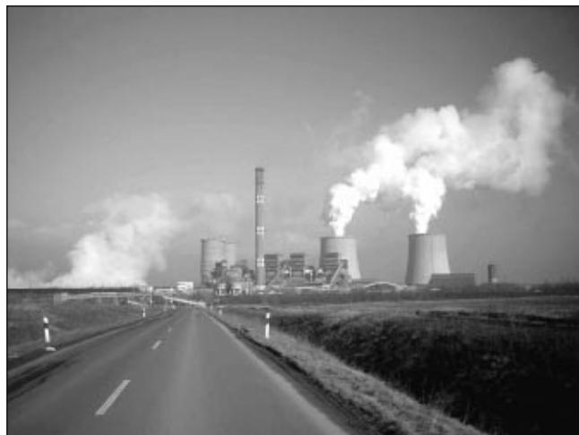
1. kép: Az erőmű távlati képe a kéntelenítőből távozó vízgőzzel (a kéntelenítő a hűtőtorny belsejében van elhelyezve)
