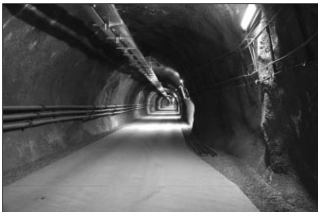
13. ábra: A szilárd burkolatú Ny-i lejtősakna a végleges közműekkel
