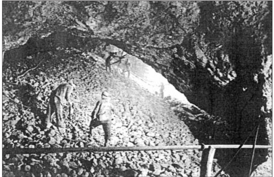
■ 5. ábra. Értárolásos, ún. magazinfejtés a Lahóca hegyi bányában
