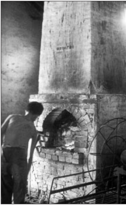
■ 6. ábra. Egy népi kommuna kupolókemencéje Zhengzhou mellett, Hubei tartomány (Kép: Voiret, 1978)
