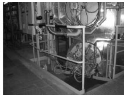
V. sz. kazán környezetvédelmi célú átalakítása, ISD POWER Kft. (2007)
