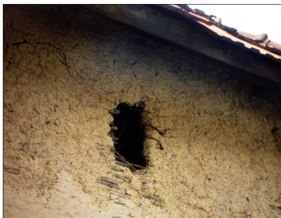
8. kép. Kétfélgű ház hátsó homlokzatának sárral tapasztott vesszőfonása (A szerző felvétele)
