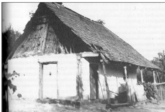
27. kép. A ház hátsó szobáját lebontották. Jól látszik a vesszőből fonott szabadkémény (Dincsér Oszkár felvétele)
