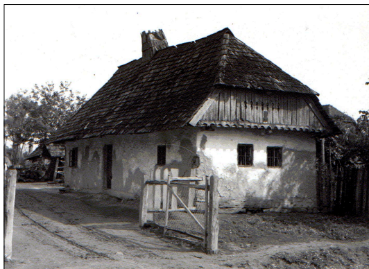
20. kép. Háromhelyiséges, talpas-vázás, ticsos falú lakóház. Zsindelyezett, csonka kontyos, fűrészelt deszka tűzfalás tetőjén jól látszik a szabad kémény tető fölé emelkedő része.
