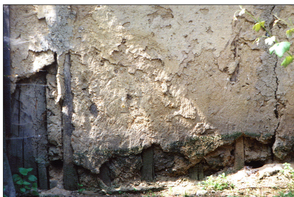
12. kép. 1937-ben épült ticsos ház sarka. Jól látszanak a sarokoszlop és a fal vázát alkotó karók végei, amelyek a talpgerendához vannak szegezve (A szerző felvétele)
