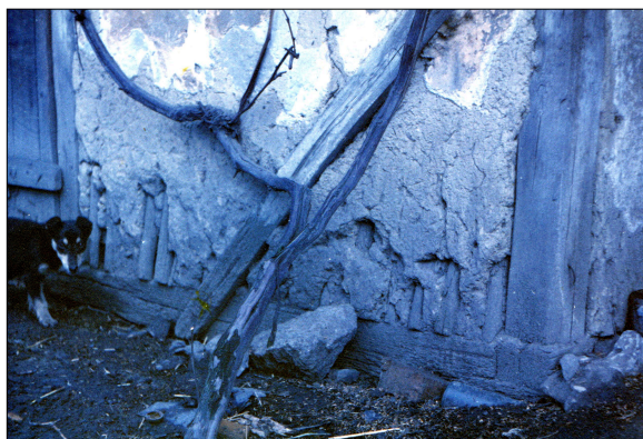
11. kép. Talpas-vázás kamra függőlegesen riglik közé szorított karókból készült ticsos fala (A szerző felvétele) Jól látható a gerendaváz és a karók vége.
