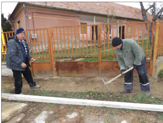
Belterületi járdák felújítása
