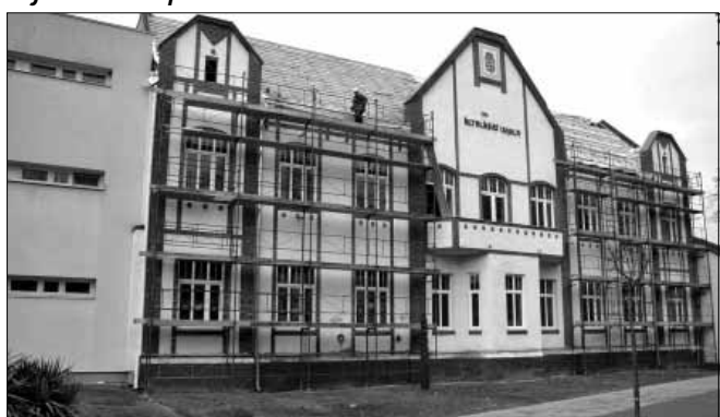
A magastető, kétszintes épületrész eternit palával fedett héjazatát cserepes lemez fedésre cserélik
