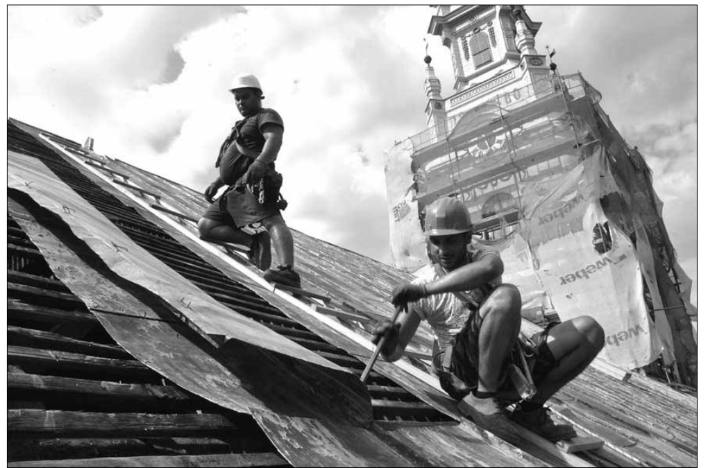
A régi bádoglemez eltávolítása a levegő 30°C feletti napi hőmérséklete miatt igencsak forró munka most
