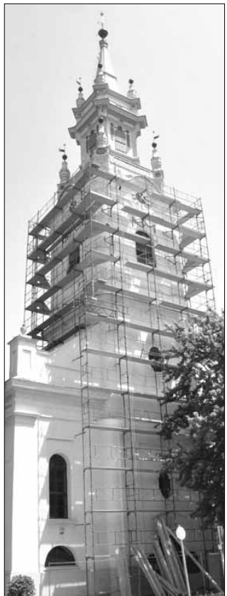
Már a munkaállványzat felépítése is „nagy munkának” számít
