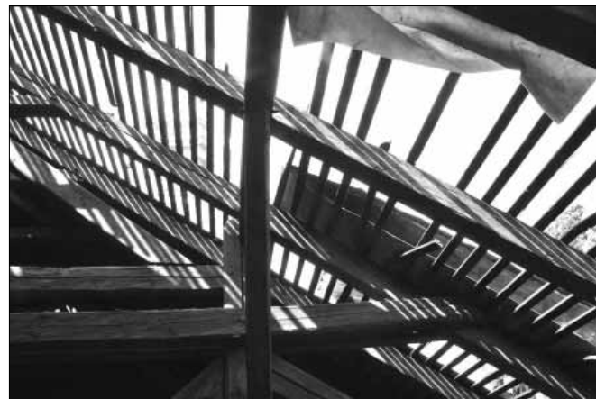
Fönt a régi, sok helyen cseréire szoruló cserépléc, alul az új, védőanyagokkal átítatott lécs a speciális fóliára szerelve
