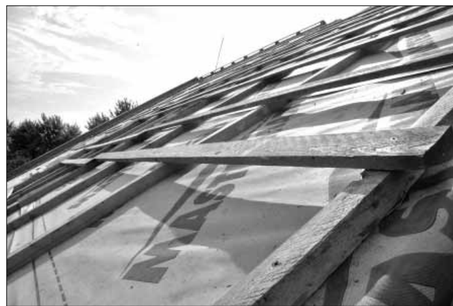
Fönt a régi, sok helyen cseréire szoruló cserépléc, alul az új, védőanyagokkal átítatott lécs a speciális fóliára szerelve
