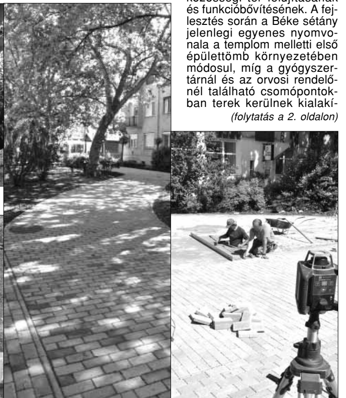
A Béke sétány felújítása során közel egymillió darab burkoló követ tesznek majd le a kivitelező dolgozói
