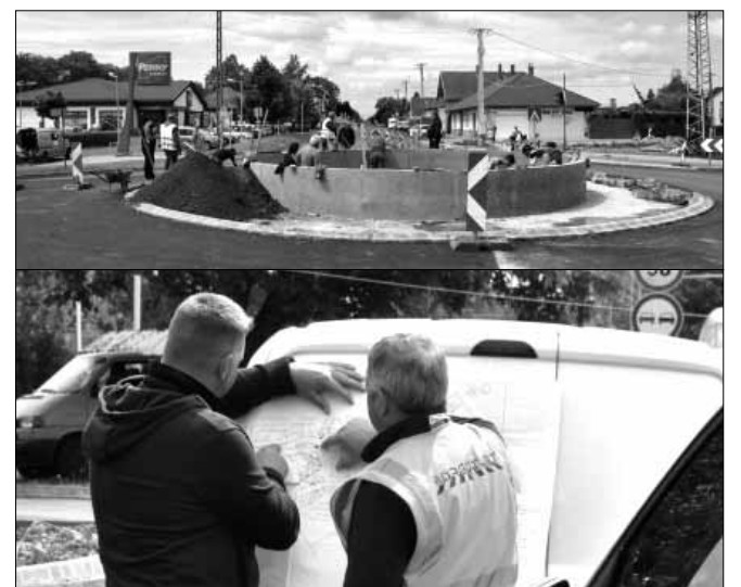
Látványosan épül a körforgalmi csomópont, a közúti forgalom nincs elterelve, forgalomirányító lámpákkal, táblákkal irányítva szinte folyamatos
