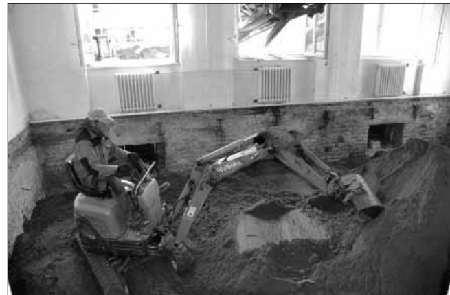
A régi épület alatti pincerendszer megszüntetése több száz köbméter töltőanyagot igényelt
