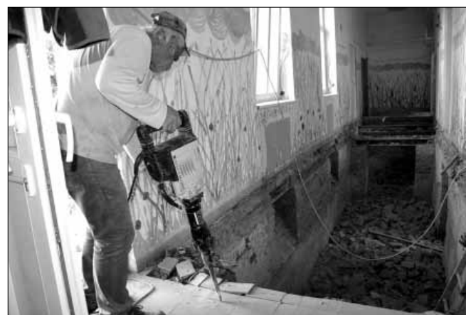
A régi épület alatti pincerendszer megszüntetése több száz köbméter töltőanyagot igényelt
