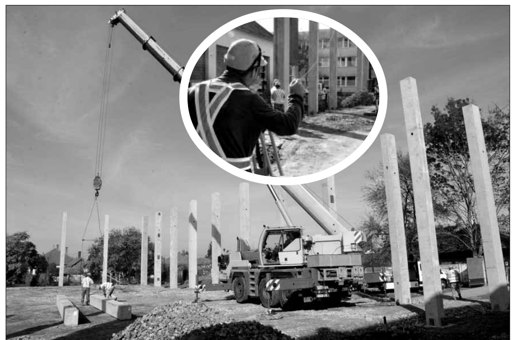
A tartópillérek (darabja 9 tonna súlyú) beemelése és rögzítése 2020. október 27-28-án megtörtént
