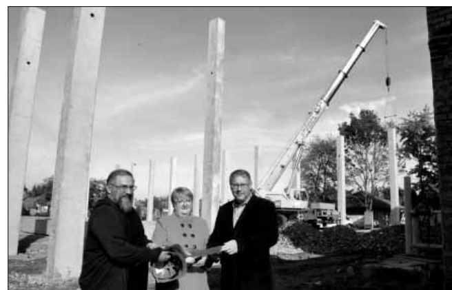
A tartópillérek (darabja 9 tonna súlyú) beemelése és rögzítése 2020. október 27-28-án megtörtént
